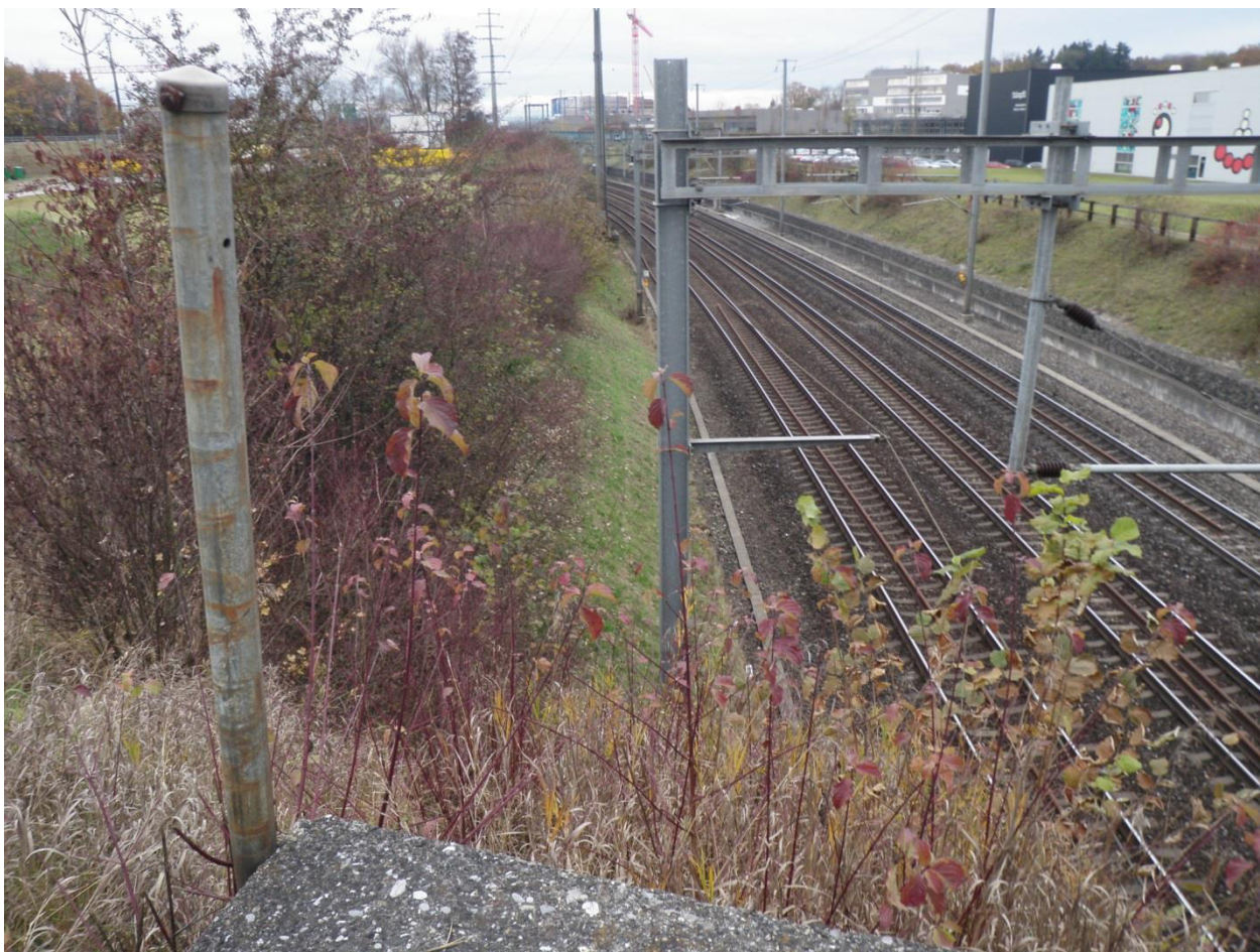
Abbildung 6: Bestehende Böschung SBB-Parzelle Nr. 4247
