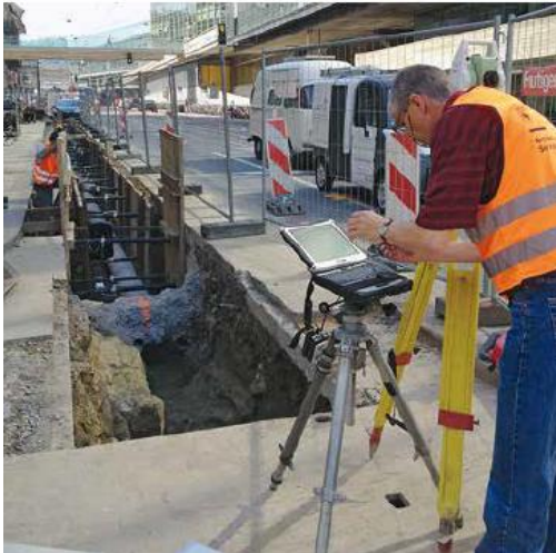
Abbildung 36: Werkleitungssanierung im Bollwerk Sommer 2013. Blick nach Süden.
