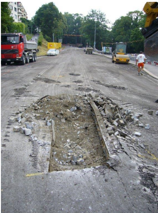
Abbildung 35: Rückbau Gleis im Bereich Neubrückstrasse/Henkerbrünkli
