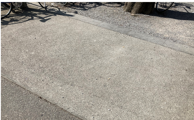
Ortbetonflächen bei Veloständern am östlichen Platzrand.
