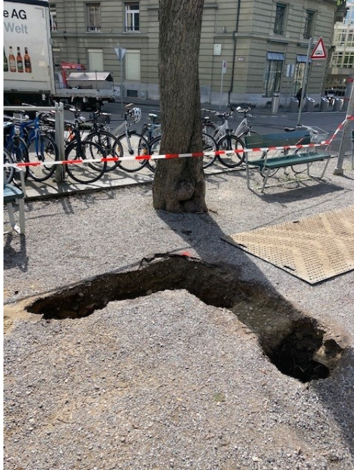
Sondierung 3 – neuer Standort Bubenberg-Denkmal Süd-Ost
