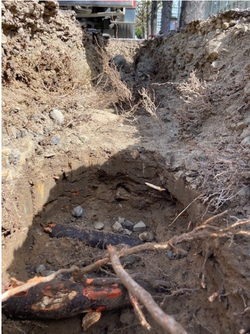
Fein- und Haarwurzeln unmittelbar unter dem eingebauten Wandkies
