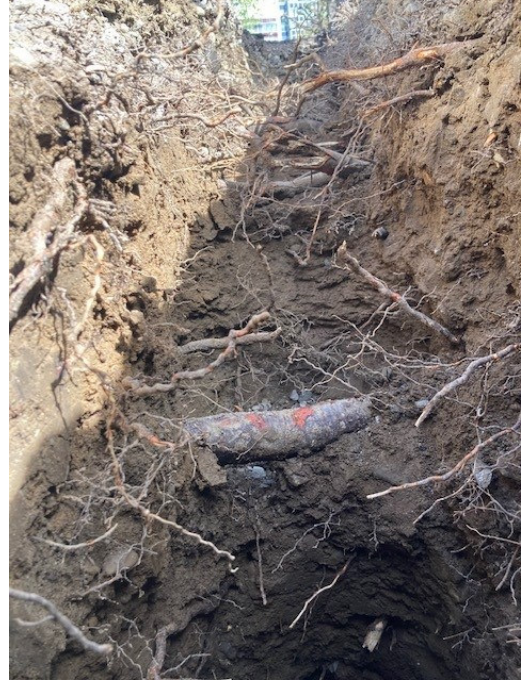
Stark- und Derbwurzeln ab einer Tiefe von 40 cm, relevant für die Standsicherheit der Bäume
