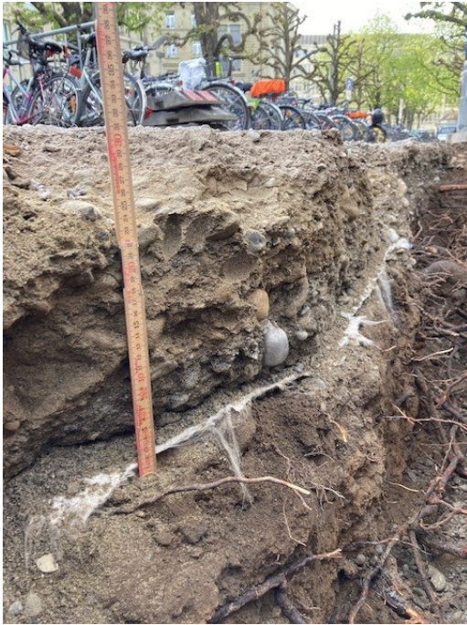
Eingebautes Wandkies wird mit Geotextil vom Unterboden abgetrennt
