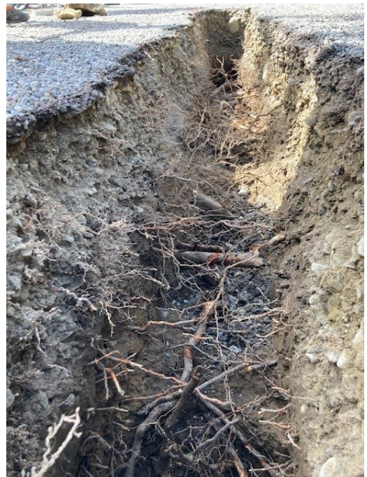
Stark- und Derbwurzeln ab einer Tiefe von 40 cm, relevant für die Standsicherheit der Bäume
