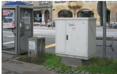
4. LSA-Verteilkabine (definierte Standorte)
